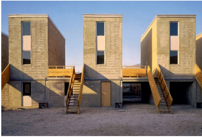
Mit Quinta Monroy setzte Elemental neue Standards im sozialen Wohnungsbau: Zustand bei Übergabe an die Nutzer, Foto: Tadeuz Jalocho, 2003.
